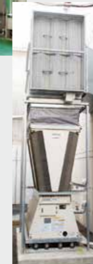
空気熱源循環加温ヒート ポンプ「CAONS」
