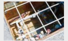
地下水と地中熱の配管が集まる地下1階の設備室
