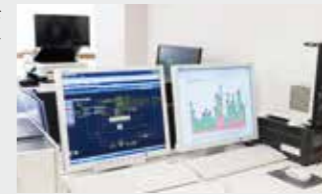
熱源システムの運転状況を確認するモニター(左)とBEMSのモニター(右)
