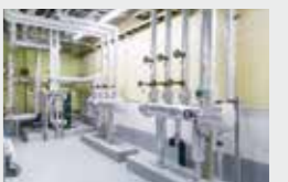
地下水と地中熱の配管が集まる地下1階の設備室
