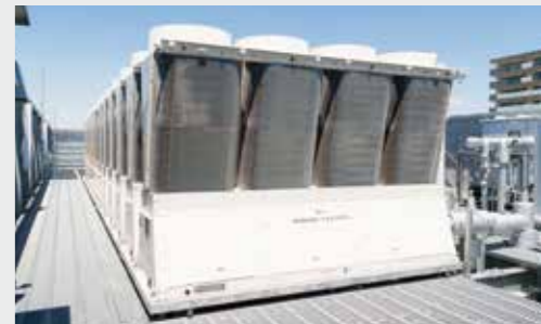
屋上に設置された高効率空気熱源ヒートポンプチャラー
