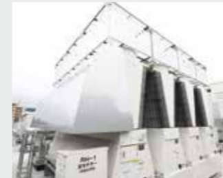
市庁舎屋上に設置された空冷ヒートポンプチャラー
