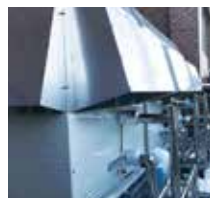
業務用エコキュート室外機
