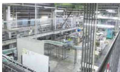
工場内のパストライザー
