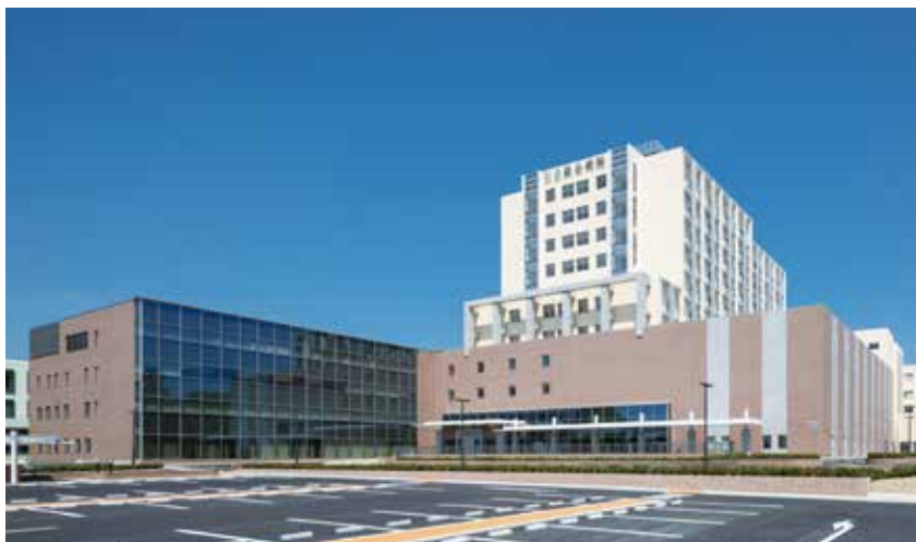
日立総合病院 本館棟
