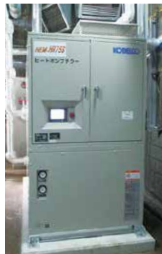
排熱回収ヒートポンプチャラー
