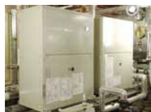
排熱回収型ヒートポンプ
