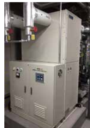
地中熱対応水冷ヒートポンプチャラー
