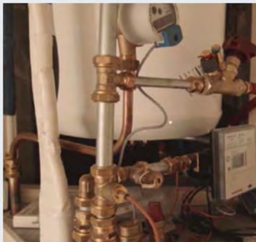
Fig. 2: 各アパートの収納キャビネット内にスマートメーターを備えた貯湯タンク (100 リットル)
