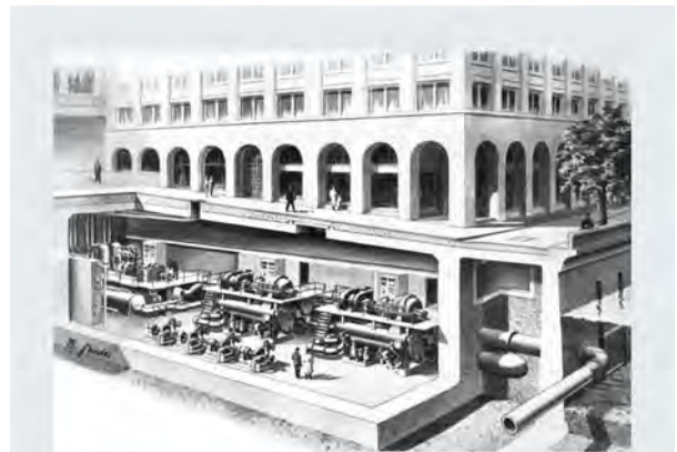
Fig. 2: Walche の 5.86MW ヒートポンププラント、1942年 [1]
