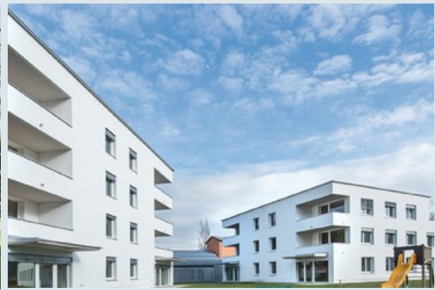
図 2：公営住宅会社 NTH（出典：NTH）によって建てられたインスブルック フェゲレビヒルのパッシブハウス・プレミアム認証の集合住宅。Annex 49 によりインスブルック大学で 4 年間に亘りモニタリング・シミュレーション研究が行われた。
