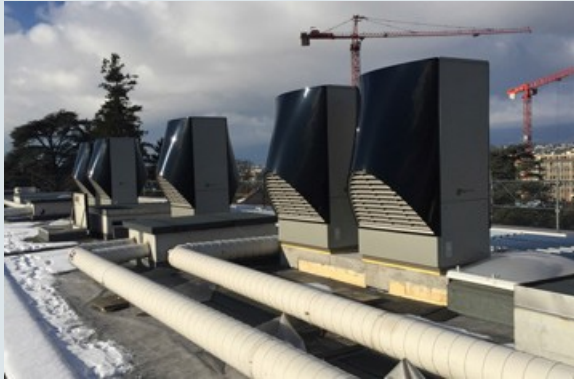
図2：ジュネーブでのエアトゥウォーターヒートポンプを用いた屋上設置の2物件。右：発生地点で騒音80dB(a)超の産業用ヒートポンプに遮音壁を設置（出典：SIG /CSD Ingénieurs SA）
