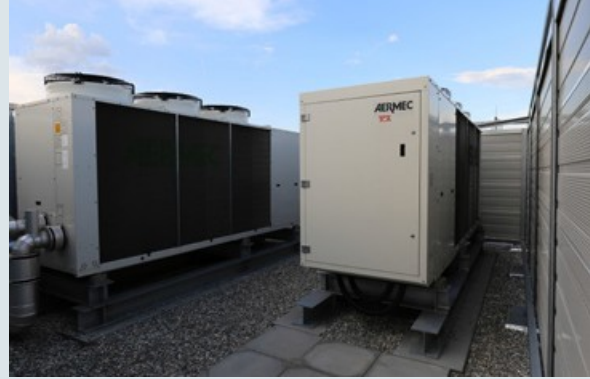
図2：ジュネーブでのエアトゥウォーターヒートポンプを用いた屋上設置の2物件。右：発生地点で騒音80dB(a)超の産業用ヒートポンプに遮音壁を設置（出典：SIG /CSD Ingénieurs SA）
