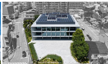
写真2 南面鳥瞰（太陽光発電設備）
