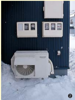
①落ち着いた紺色のガルバリウムと明るい色の塗り壁仕上げを組み合わせた印象的な外観 ②エコキュートの室外機 ③エコキュートを設置した1階洗面所。シンプルな角形ですっきりと収まっている
