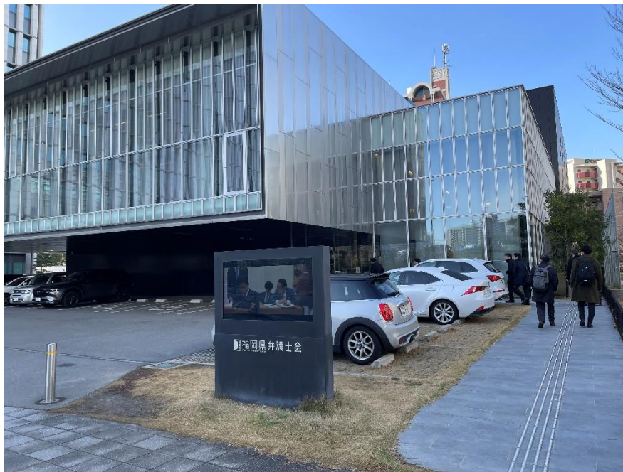
福岡県弁護士会館（GHP 使用 ZEB 建築）
